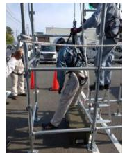
※ 建設業における墜落による死亡災害は全体の4割を占めています。また墜落災害は重症化率の高い災害であり、その防止のため、足場の設置等による作業床がない箇所や解体中の屋根端等で2m以上の高所等で作業を行う際はフルハーネス型安全帯の使用義務が設けられています。正しい着用の教育を行います。
